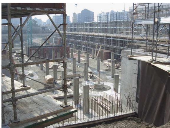
fig. 3 Progetto “Grazioli”, il cantiere
